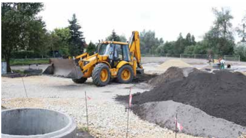
■ Budowa nowego parkingu w trakcie
