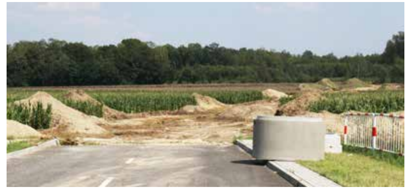
■ Budowany jest nowy odcinek drogi przy ulicy Strefowej
