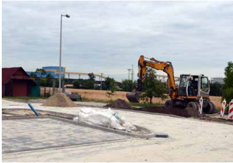
■ Nowe miejsca parkingowe w trakcie budowy
