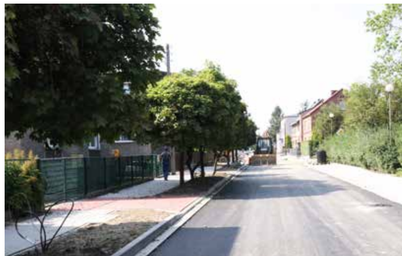
■ Już za niedługo zakończy się remont na ulicy Remizowej
