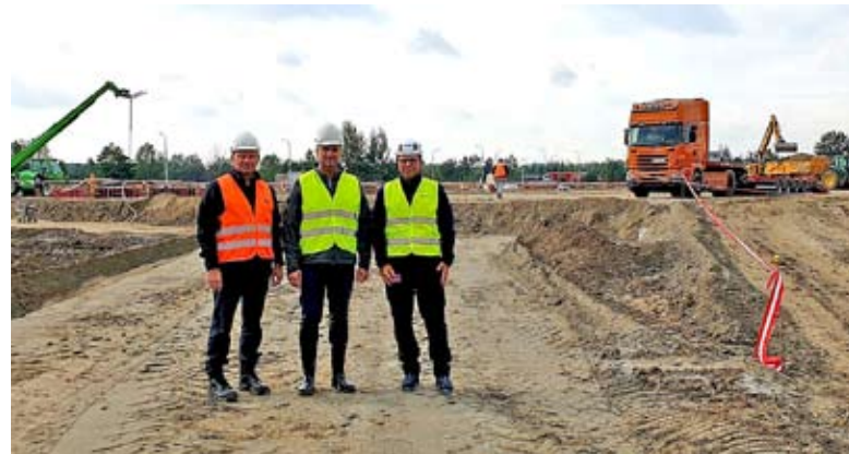
Niedawno plac budowy odwiedził burmistrz Bierunia Krystian Grzesica (w środku).
